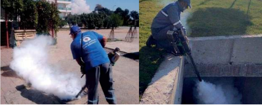
Şekil 4. Bir rögarda ve yağmur suyu kanalında sıcak sisleme cihazı kullanılarak yapılan biyosidal ürün uygulamaları
